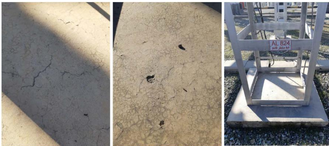
انتخاب پایه بتنی خط منتظر قائم پست ازگل برای اجرای دو نمونه نانو پوشش محافظ. شروع فرایند تخریب سطحی بتن بصورت ترک و کندگی در تصویر دیده می شود.
