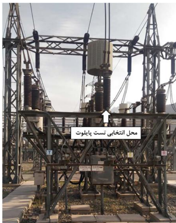
محل انتخابی تست پایلوت پوشش بر سطح برقگیر در خط سعیدیه پست مشیریه
