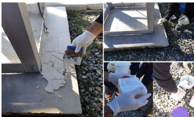
مراحل آماده سازی و اجرای نانوملالت ترمیمی بر روی سطح پایه بتنی خط منتظر قائم پست از گل
