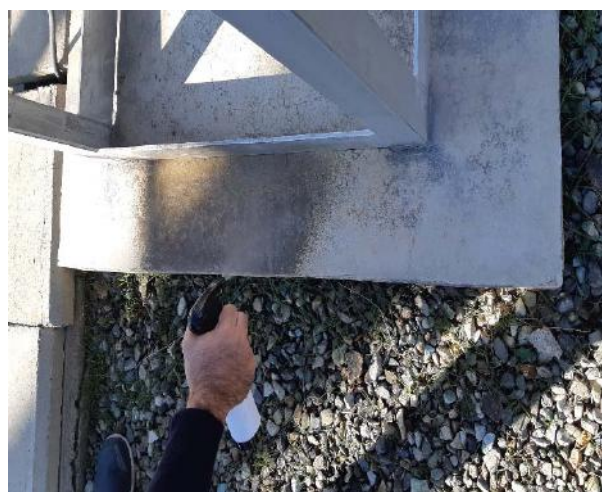
اعمال نانو پوشش دوم محافظ بتن بصورت اسپری نانو مواد ابرآبگریز کننده بر روی سطح پایه بتنی
