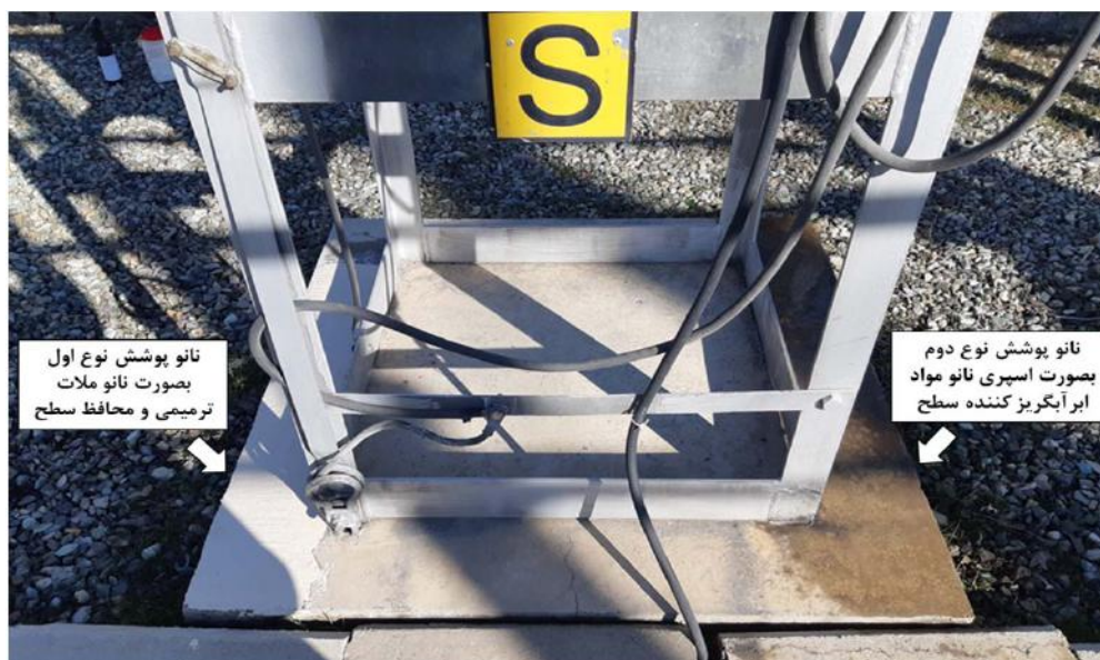
دو نوع نانو پوشش اعمال شده بر روی سطح پایه بتنی خط منتظر قائم پست از گل بصورت نانوملالت ترمیمی و محافظ و اسپری نانو مواد ابرآبگریز کننده
